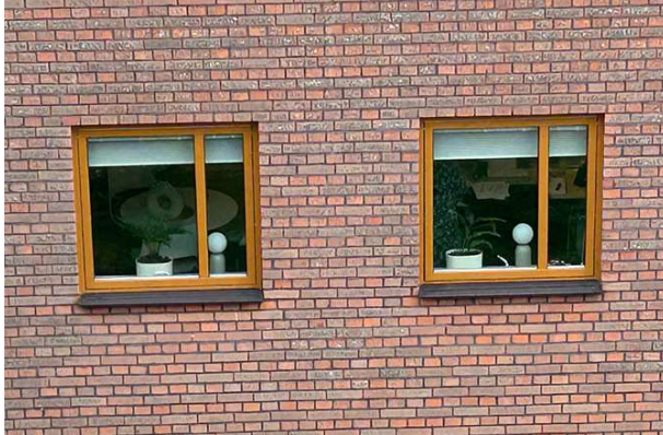
Nya fönster i Stadshuset.
