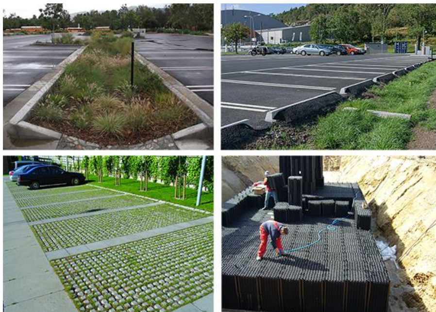
Figur 14 visar olika exempel på tekniska lösningar för anläggning av fördröjningsvolym
