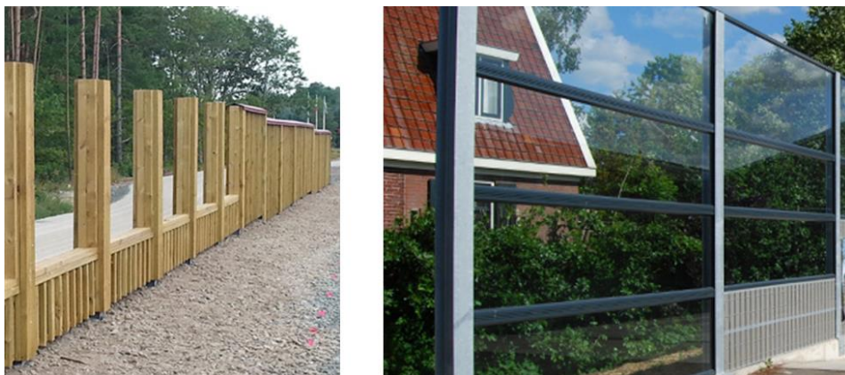
Figur 10 visar olika förslag på utformning av bullerskärmar. Bullerskärmsystem av trä och glas som kan anpassas efter önskemål och smälter in i omgivningen på ett naturligt sätt 5 .
